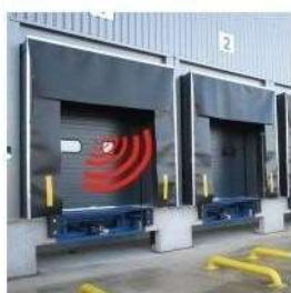
Sensori Avvicinamento camion per consenso attrezzature
